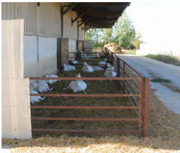
Un exemple d'aire bétonnée couverte (= avec un toit)
